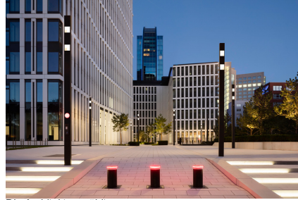
Die Architekten wählten maßgeschneiderte „EL“-Stelen von Ewo am Treppenaufgang und auf dem Plaza, die nicht nur Sicherheit und Orientierung im Dunkeln bieten, sondern auch hervorragend mit der Architektur des Towers korrespondieren. Foto © Hans Georg Esch/ewo
