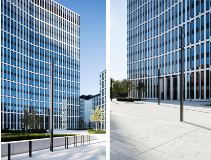
Schlanke Stelen, viel Technik: In das äußerst formreduzierte, schlanke Gehäuse der Leuchten mussten noch zusätzlich Sprechanlagen und Ampel- Systeme integriert werden. Foto © Hans Georg Esch/ewo
