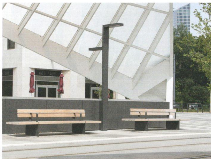
Abb.: Mastleuchten mit direkt und indirekt strahlendem Lichtanteil leuchten die Bahnsteige aus und lassen die mit ETFE-Folie gestaltete Dachkonstruktion als selbstleuchtend erscheinen. Foto: Johann Lichtl
