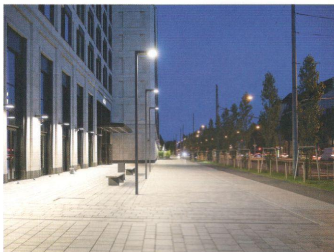
Abb.: Die Lichtpunkthöhen der Leuchten sowie die Abstände der insgesamt etwa 200 Lichtpunkte sind über das ganze Quartier hinweg gleich angelegt, um eine formale Durchgängigkeit zu erreichen. Foto: Johann Lichtl
