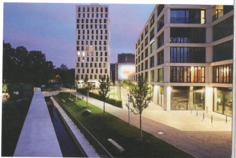
Abb.: Neben den drei Hochhäusern verfügen die restlichen Gebäude über sechs oberirdische Etagen. Die hellen Lichtpunkte entlang der Fassaden setzen eine prägnante Kontur aus Licht. Foto: Jost Hurler Gruppe
