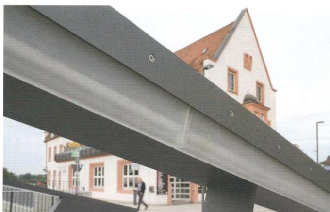
*Abb.: Für die Bogenbrücke wurde eine Sonderleuchte entwickelt, die als durchgängiges Lichtband zur Fußgängerseite verläuft. Diese übernimmt die Akzent- und Funktionsbeleuchtung der Verkehrswege. Foto: Conné van d'Grachten*
