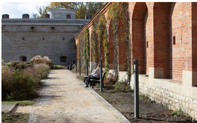
Abb.: Die Leuchten wurden mit einer neu entwickelten Antiposter- und Antigraffiti-Beschichtung behandelt. Der LED-Bereich wird durch schlagfestes Glas in IK 10 geschützt.
