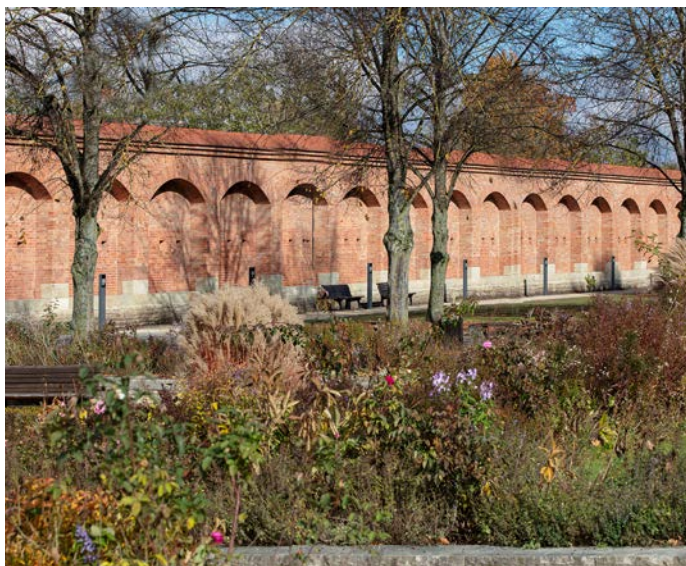
Abb.: Die neuen Lichtstelen fügen sich auch tagsüber unauffällig in das Gesamtbild des Parks ein. Mit einem speziellen Steuergerät können Lichtfarbe und Lichtleistung jederzeit verändert werden.
