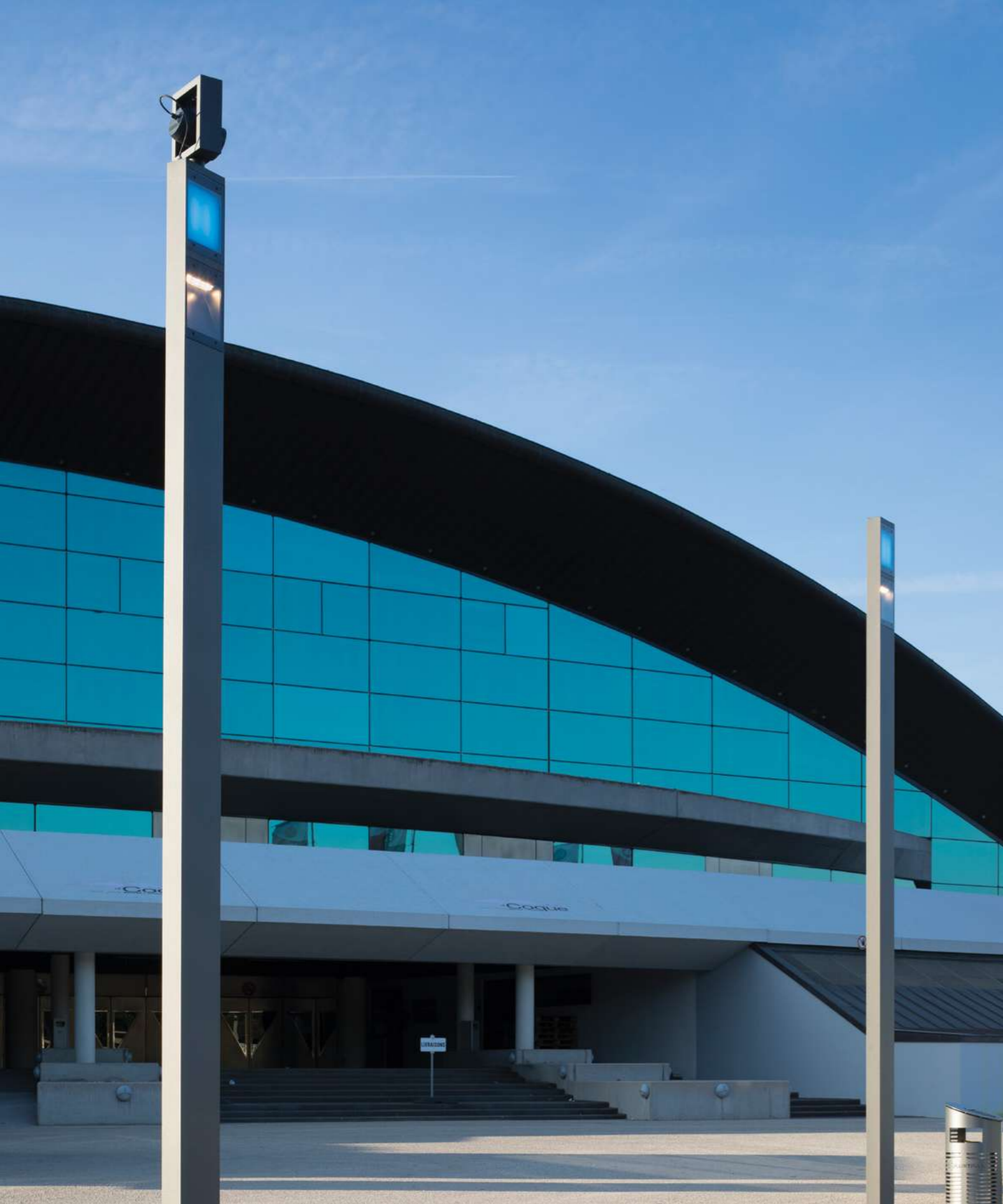
Fonctionnalité grâce à la modularité – colonnes lumineuses équipées de lentilles RVB pour communiquer les signaux d'entrée, d'arrêt ou de passage du tramway
