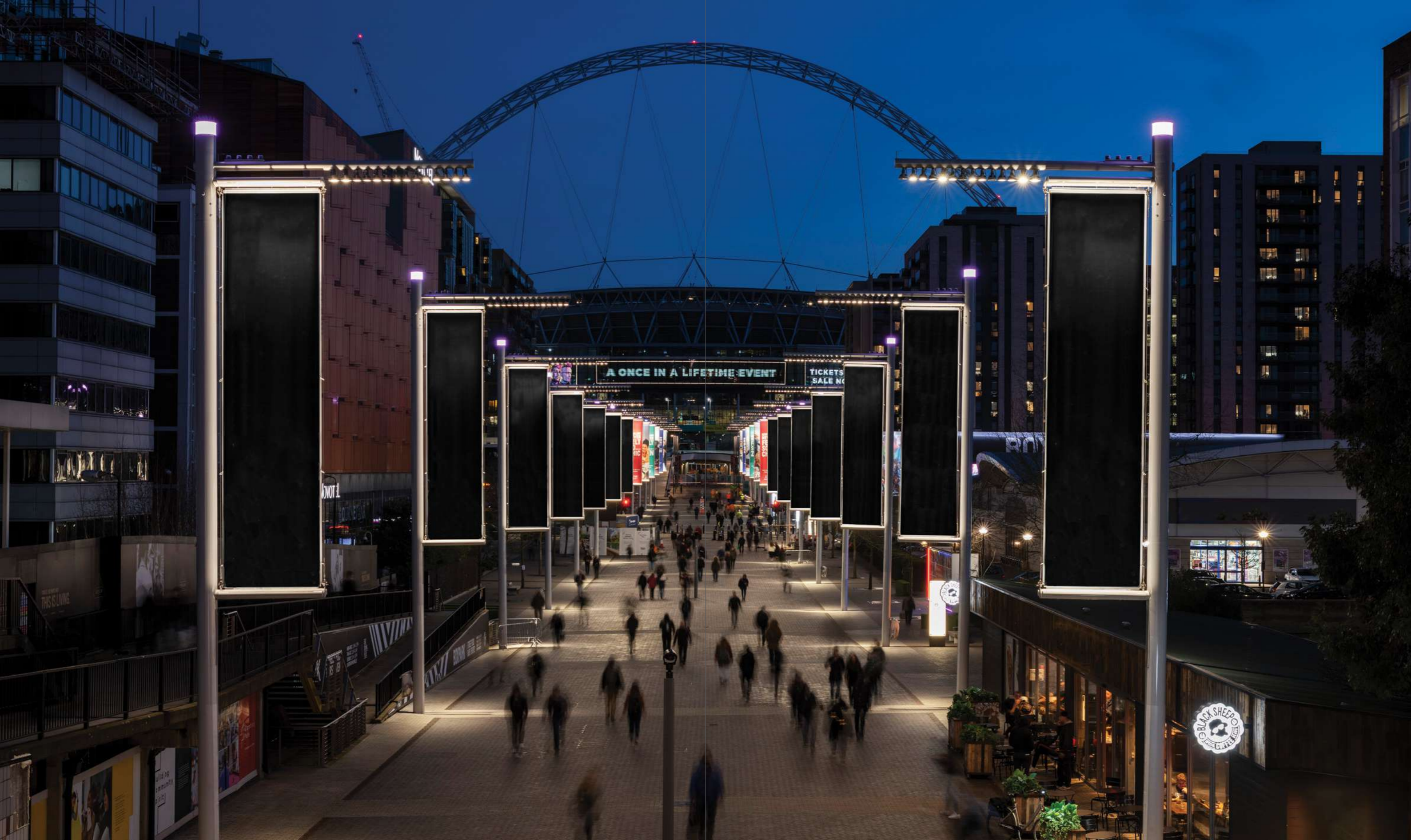
Un éclairage scénographique et conforme aux normes de sécurité pour les visiteurs du stade et les habitants de la ville
